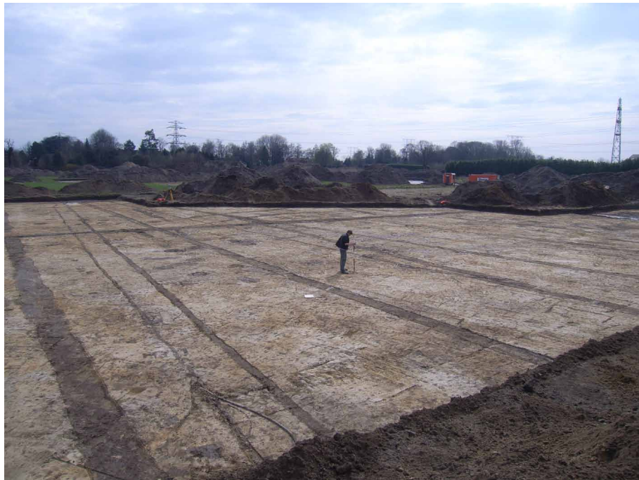
Afb. 1.02 Voor het overzicht zijn grote werkputten aangelegd.
